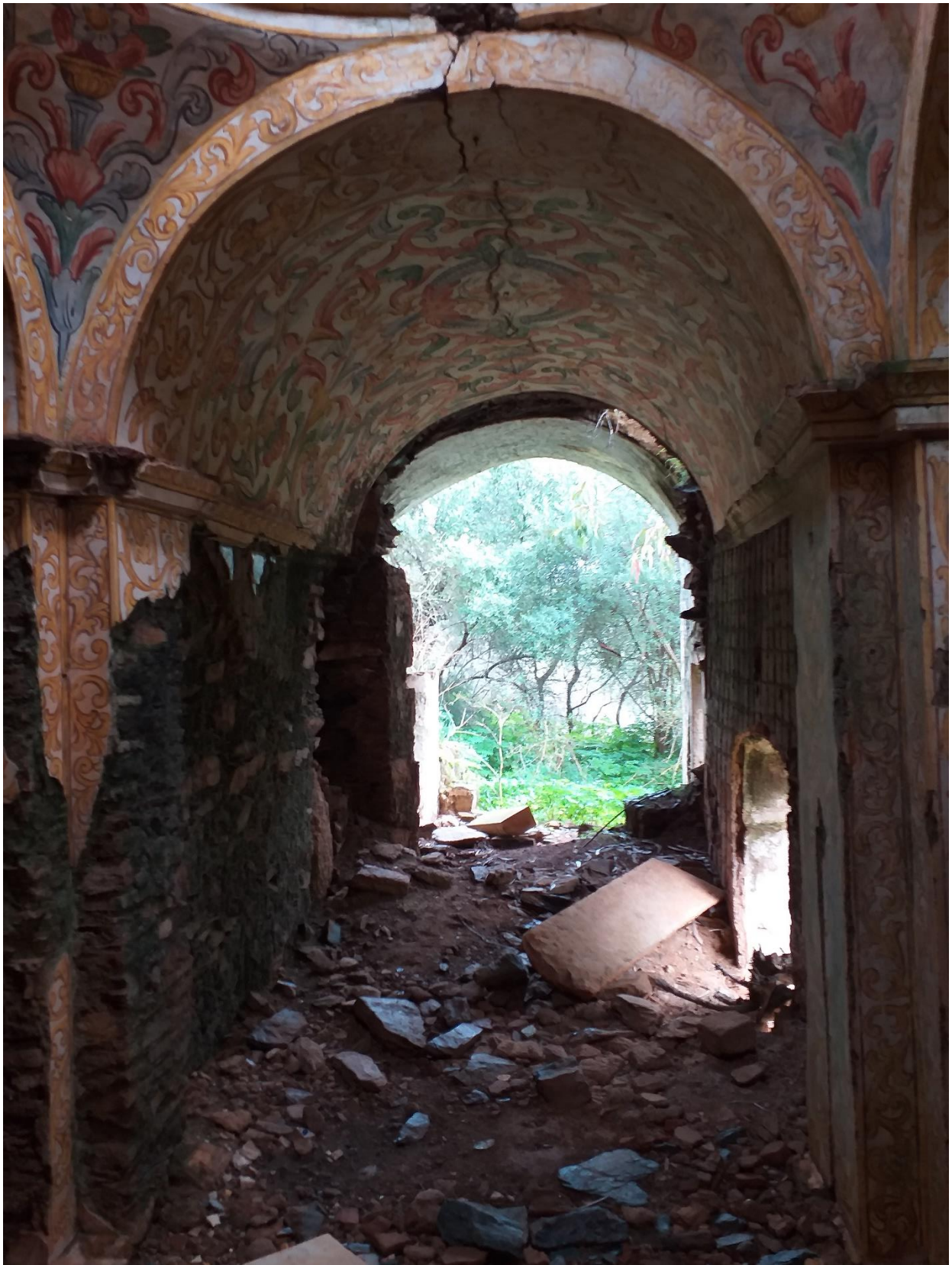
Ermita de Nossa Senhora do Paraíso – Zona da nave e abóbada
