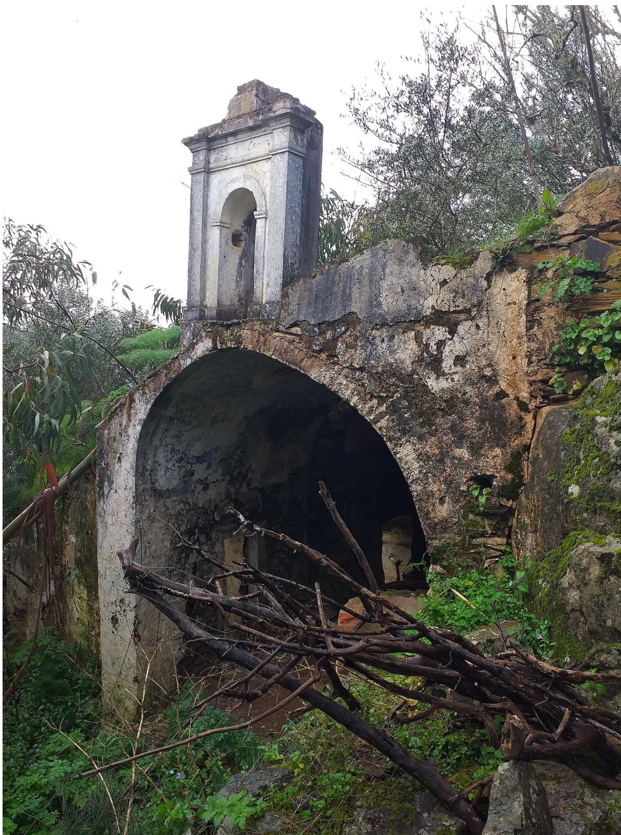
Ermida de Nossa Senhora do Paraíso – Fachada axial, voltada a norte
