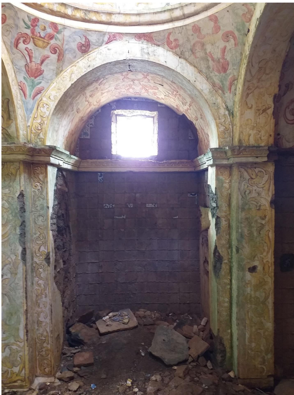
Transepto da Ermida de Nossa Senhora do Paraíso, com evidentes sinais de vandalização a nível do revestimento azulejar
