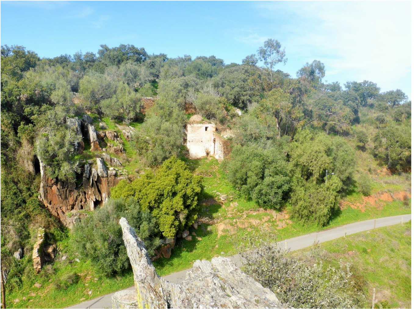
Ermida de Nossa Senhora do Paraíso de Vila Viçosa – vista geral
